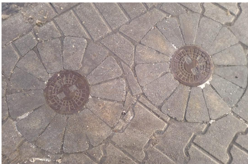
fot. obróbka armatury wodociągowej
